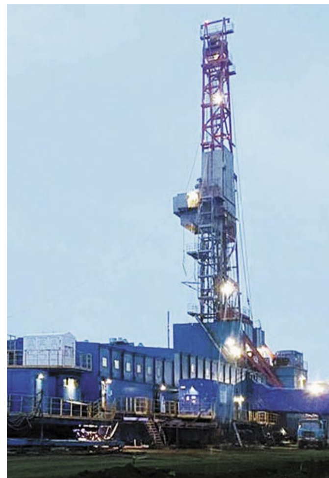
Буровая установка на КП-37
