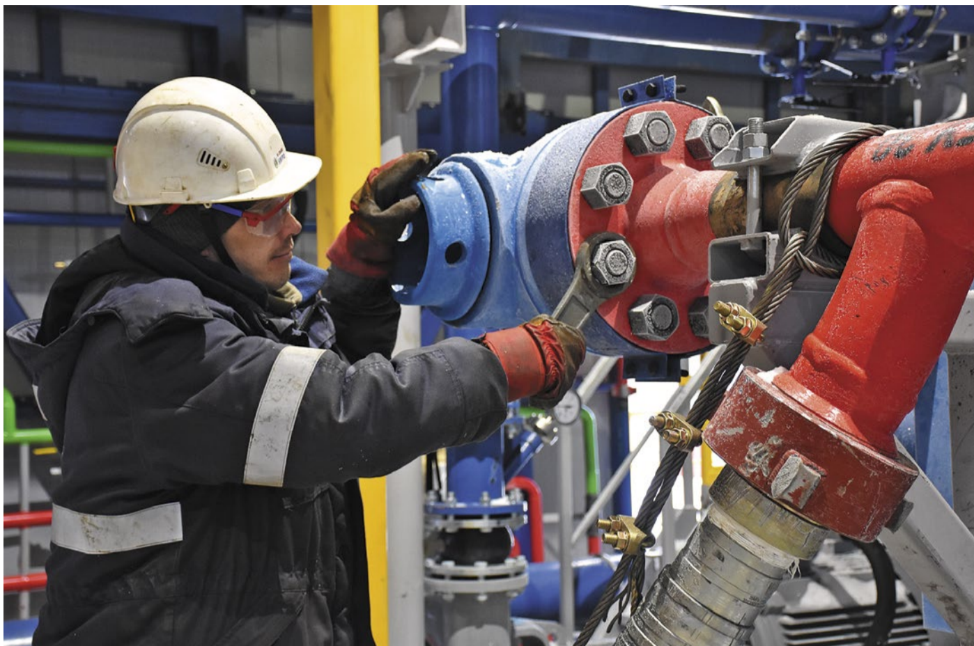
Ведущий специалист Службы по вышкостроению и обустройству месторождений Вячеслав Зямзин выполняет настройку третьего бурового насоса
