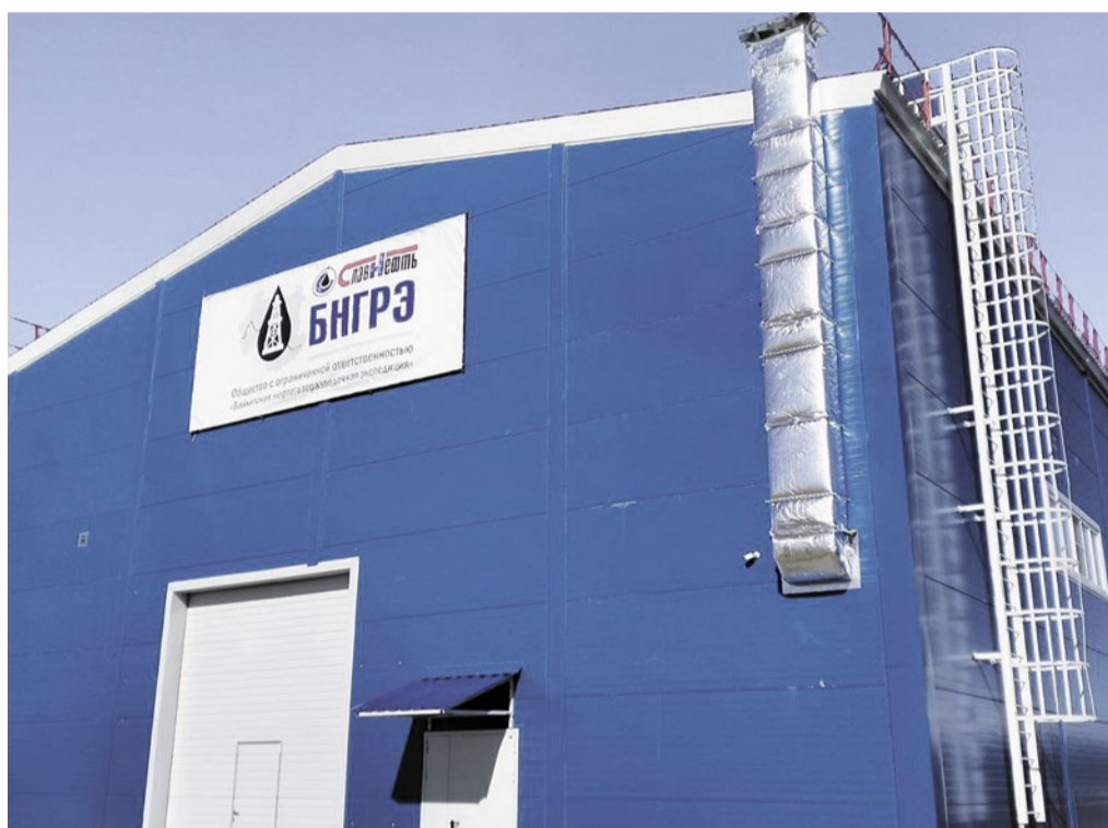
Ангар ремонтно-механической мастерской
